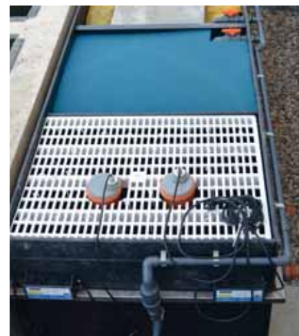
Obr. 6: instalace v nátokové komoře biologické filtrace
