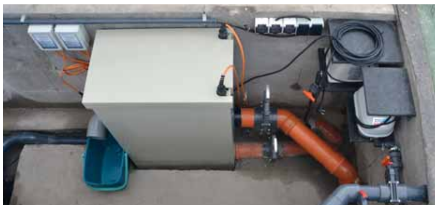
Obr. 4: instalace do nátokové komory štěrbinového předfiltru
